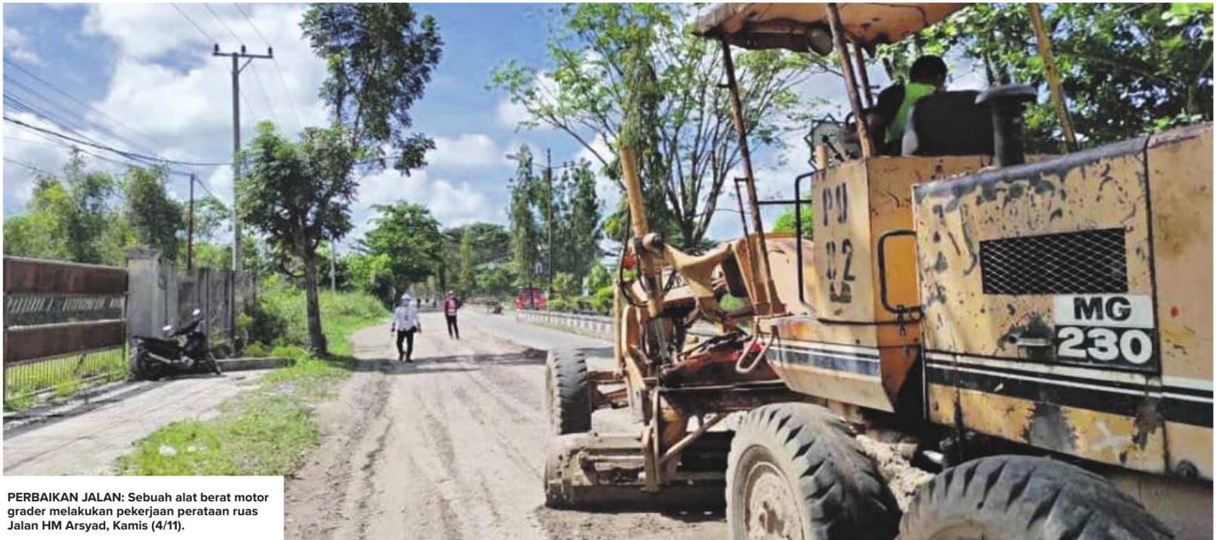
**PERBAIKAN JALAN:** Sebuah alat berat motor grader melakukan pekerjaan perataan ruas Jalan HM Arsyad, Kamis (4/11).
