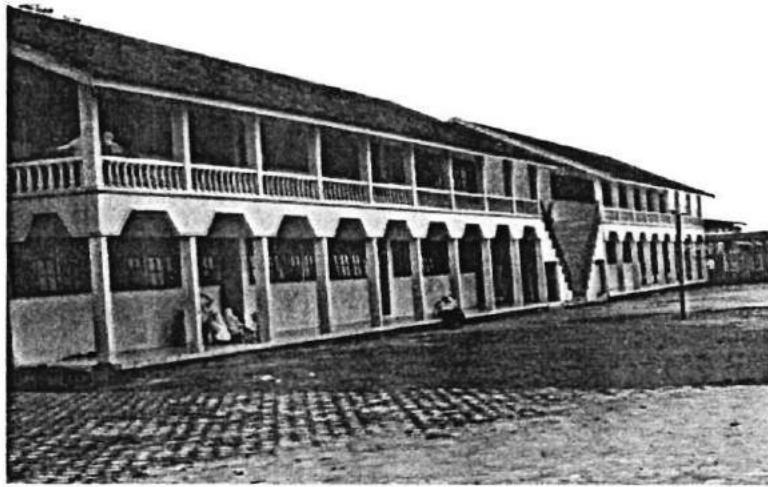
Ruang bangunan MTs
