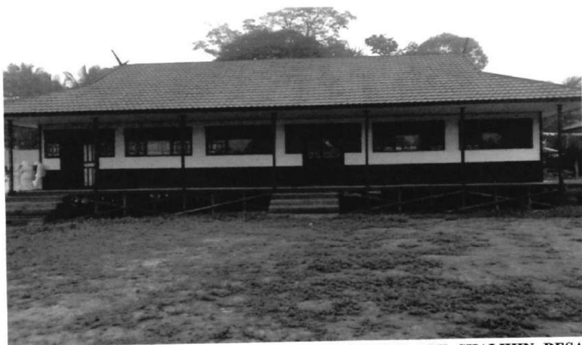
GAMBAR 8. GEDUNG KELAS MADRASAH ALIYAH ASH SHALIHIN DESA SAMBA BAKUMPAI KECAMATAN KATINGAN TENGAH KAB. KATINGAN
