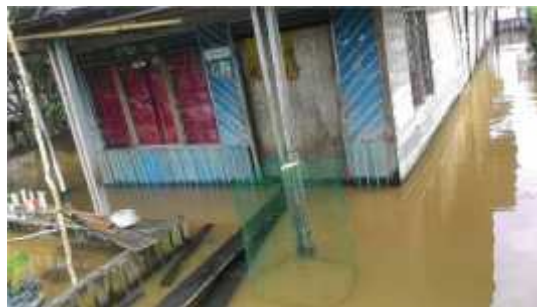
Gambar 1 Kondisi Rumah Warga Danau Tundai Ketika Terendam Air Pasang
